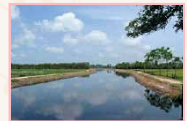
การขุดลอกคลองเพื่อระบายน้ำออกจากพื้นที่ป่าพรุโต๊ะแดง
