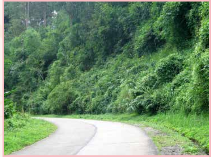
การปลูกหญ้าแฝกเพื่ออนุรักษ์ไหล่ทางลาดชันตามถนนที่ตัดใหม่ภายในสวนพฤกษศาสตร์สมเด็จพระนางเจ้าสิริกิติ์ จังหวัดเชียงใหม่ เริ่มปลูกปี ๒๕๓๗ (ซ้าย) และความสัมฤทธิ์ผลในปี ๒๕๓๙ (ขวา)
