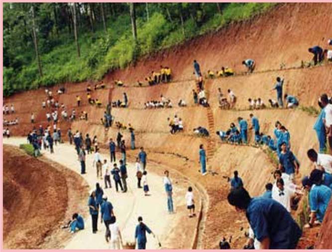
การปลูกหญ้าแฝกเพื่ออนุรักษ์ไหล่ทางลาดชันตามถนนที่ตัดใหม่ภายในสวนพฤกษศาสตร์สมเด็จพระนางเจ้าสิริกิติ์ จังหวัดเชียงใหม่ เริ่มปลูกปี ๒๕๓๗ (ซ้าย) และความสัมฤทธิ์ผลในปี ๒๕๓๙ (ขวา)
