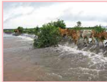
สภาพน้ำจากพรุโต๊ะแดงไหลข้ามคันกั้นน้ำชายขอบป่าพรุโต๊ะแดง
