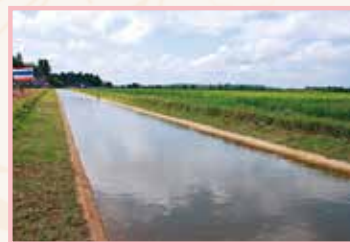
การขุดลอกคลองเพื่อระบายน้ำออกจากพื้นที่ป่าพรุโต๊ะแดง
